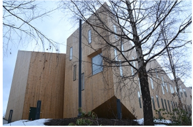
Nybygget fra syd
